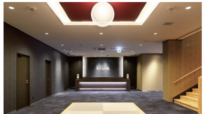
高品位な空間デザインに溶け込むように設計・施工された空調・換気設備（1階ホール）
