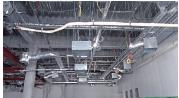
天井埋込ダクト型天井内据付状況
