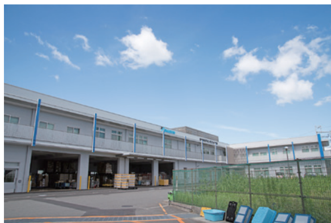
2018年6月に竣工した新事務所棟
