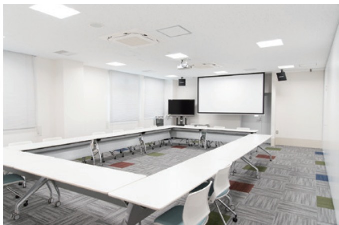
使用時間が限定される食堂や会議室には、立ち上がりの速い一般的なオフィス空調を採用した
