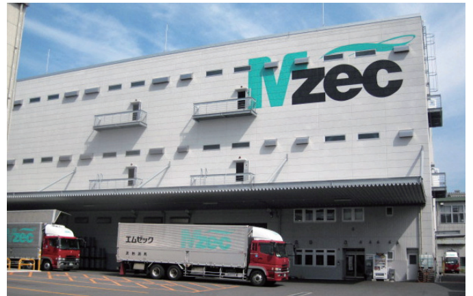
今回ゼッフル遮熱塗装を施工した追浜2号倉庫（神奈川県横須賀市）
