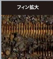
熱交換器表面にホコリが付着し写真の様にフィンの隙間が全面的に詰る状態になっています。(硬い付着物)この状態になると、冷房時では水漏れ、暖房時であれば、室外機の異常停止が発生します。この状態で御使用されると風量の低下により空調不良が発生し、室外機に過度のストレスを与え故障の原因になります。
