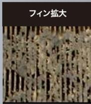
ホコリ又は煙草のヤニが付着した状態です。(柔らかい付着物)この時期から、冷房時であれば水漏れ、吹き出し口からの水飛びが発生し始め、暖房時であれば室外機の異常停止が発生する可能性があります。
