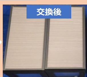
フィルターや熱交換エレメントにゴミやホコリが詰まっていると、空気の通り道が塞がれキレイな空気の入替えが出来なくなってしまいます。換気量確保のために定期的な清掃・交換が必要です。
