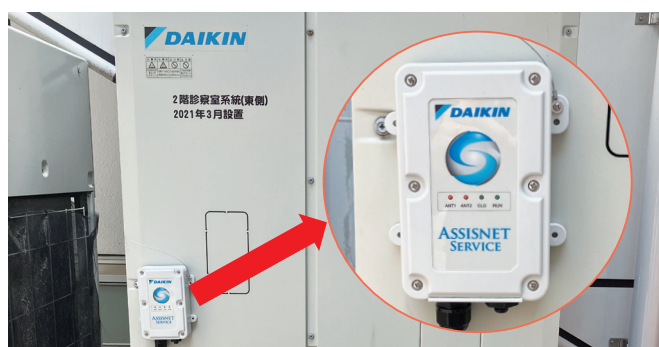
室外機に取り付けたアシスネットのIoT端末
