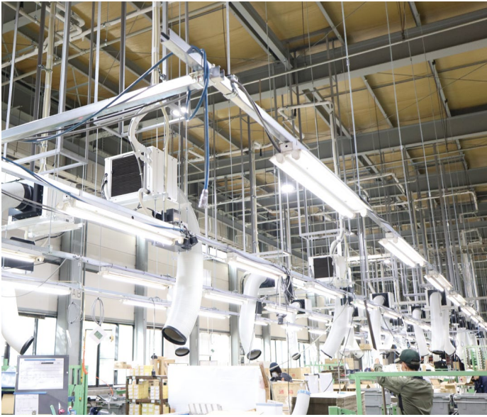
MULTI CUBEは1台ごとに温度設定（冷・暖）ができるため、体調に合わせた温度設定が可能
