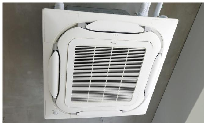
新しく設置されたガスヒートポンプエアコンの室内機
