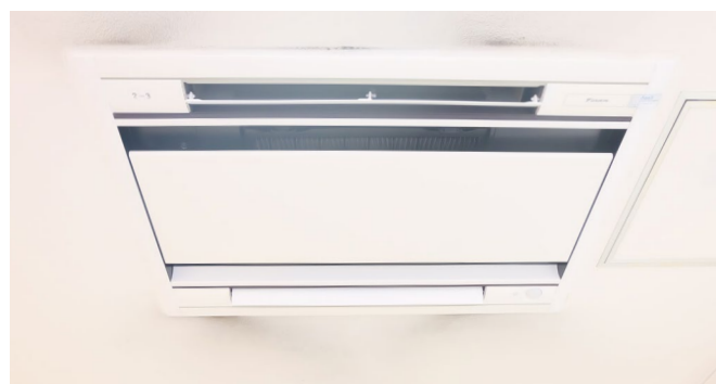
B棟に設置されたダイキン製空調機（室内機）
