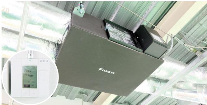
2階フロアに設置した露出型ベンティエール。左下のコントローラーで自動換気モードに設定すればCO<sub>2</sub>濃度も監視できる。
