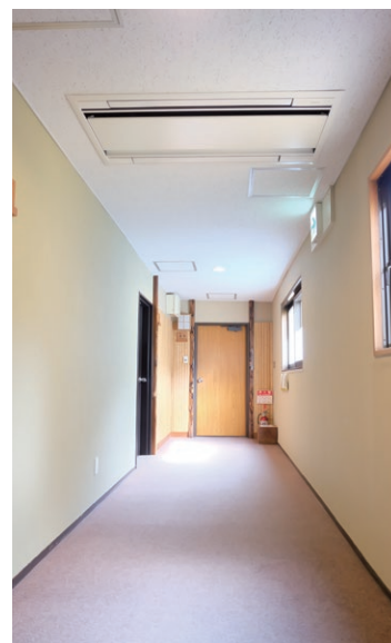
廊下にも空調機を設置し、より快適に過ごしていただけるように
