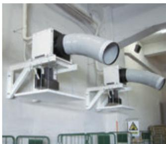
天井が高く間隔を空けて設置する場所では特注の据付台を用意
