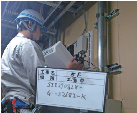
EMS設置工事
