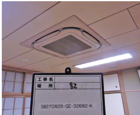
工事が完了した和室
