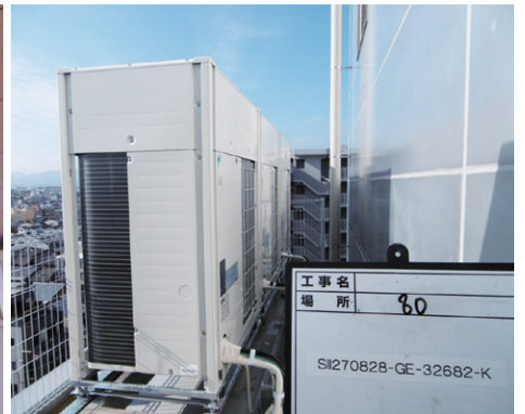
更新された室外機
