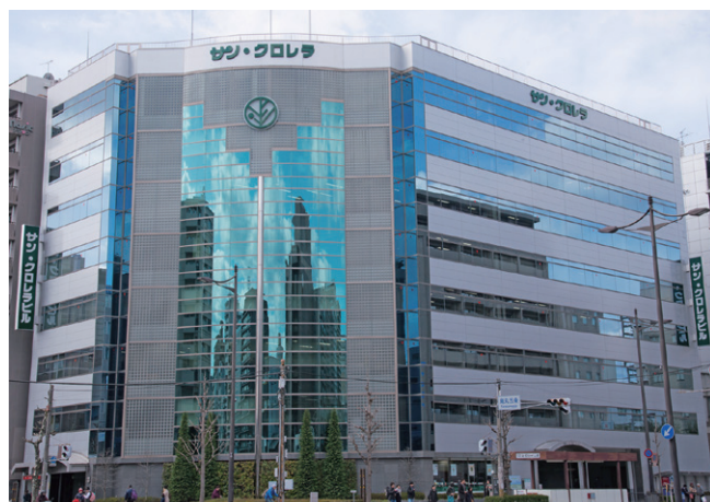
今回省エネ改修を実施した本社ビル(京都市下京区)
