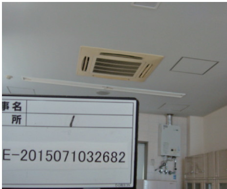
空調更新工事前の室内
