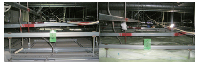
断熱材敷設前の天井裏
