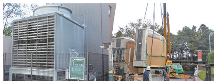
撤去前の冷却塔
