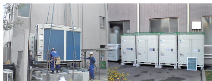
空冷ヒートポンプチャラーの据付
