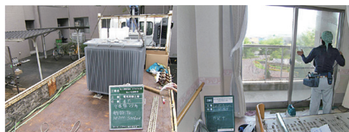
受電設備の更新
