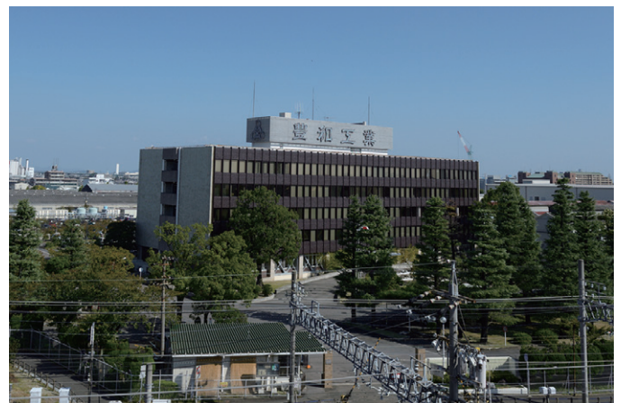
今回省エネ改修を実施した本館ビル（中央）。234,246㎡の敷地に工場棟など十数棟が並ぶ
