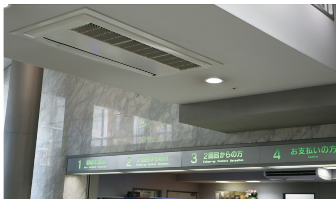
エアアズアサービス導入を機に入れ替えた1階受付の室内機
